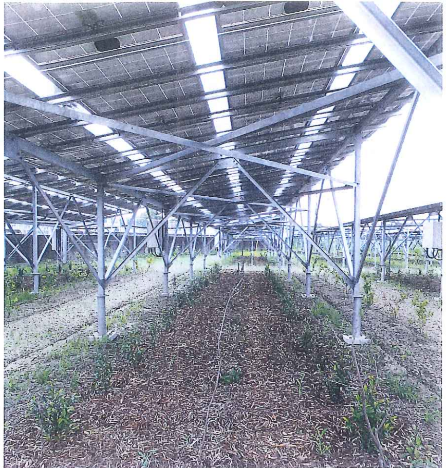
美里町に建設されたパイロットプラント(4.8kW×3)。パネルはCNPVソーラー・パワー社製
